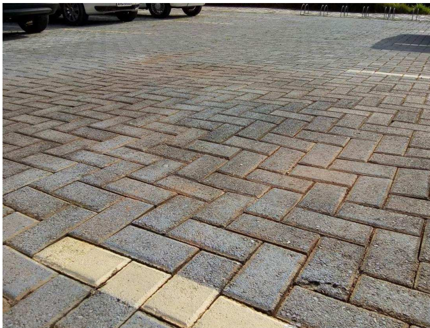
Imagem 31 - Pavimento tipo Paver com recalque
