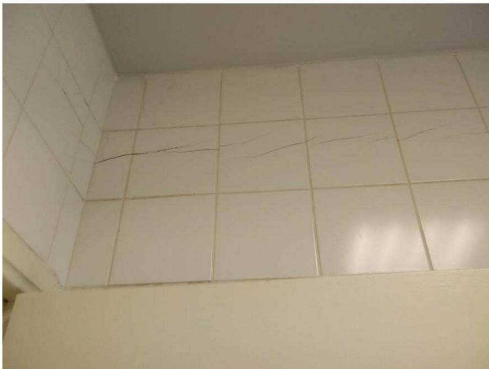
Imagem 33 - Trincas em revestimento cerâmico.
