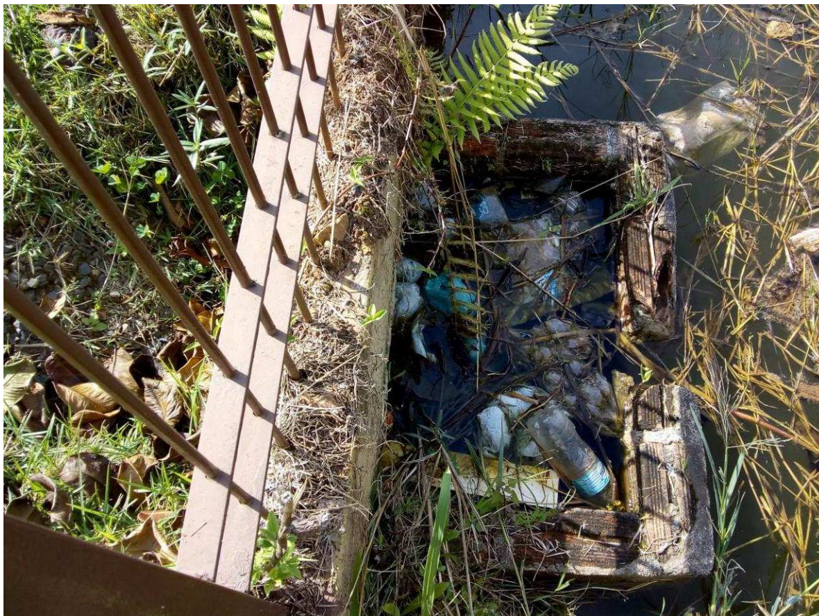
Imagem 23 - Escoamento do lagoa entupido
