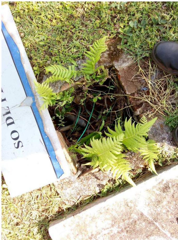
Imagem 42 - Caixa de Passagem sem tampa
