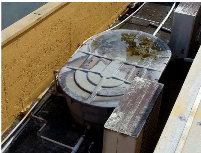
Imagem 28 - Caixa d'água com acúmulo na tampa
